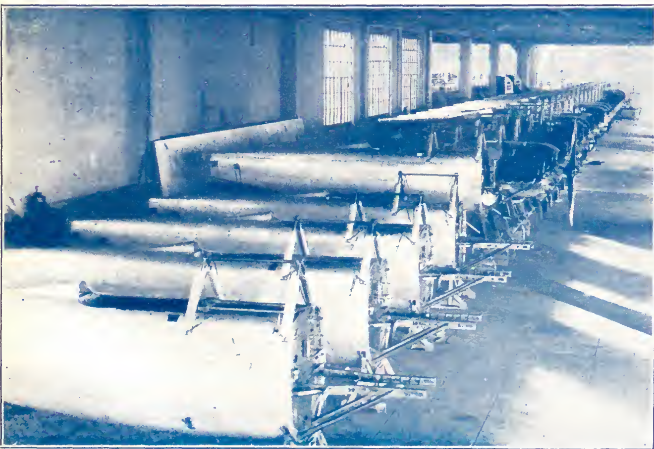
Nei cantieri ANSALDO. L'allestimento di una serie di apparecchi metallici
